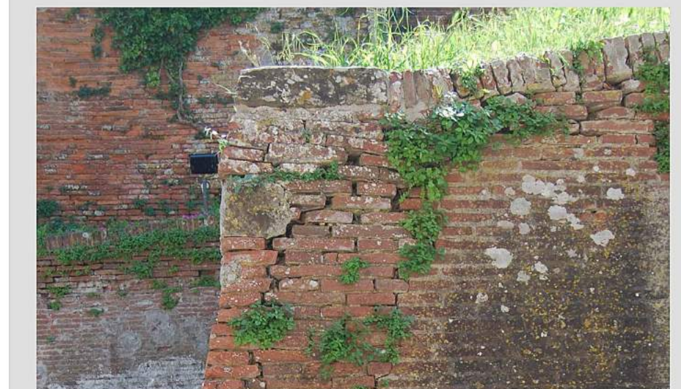
FOTO 5: Dettaglio delle mura su piazza G. Marconi Intervento proposto: TIPO 5
