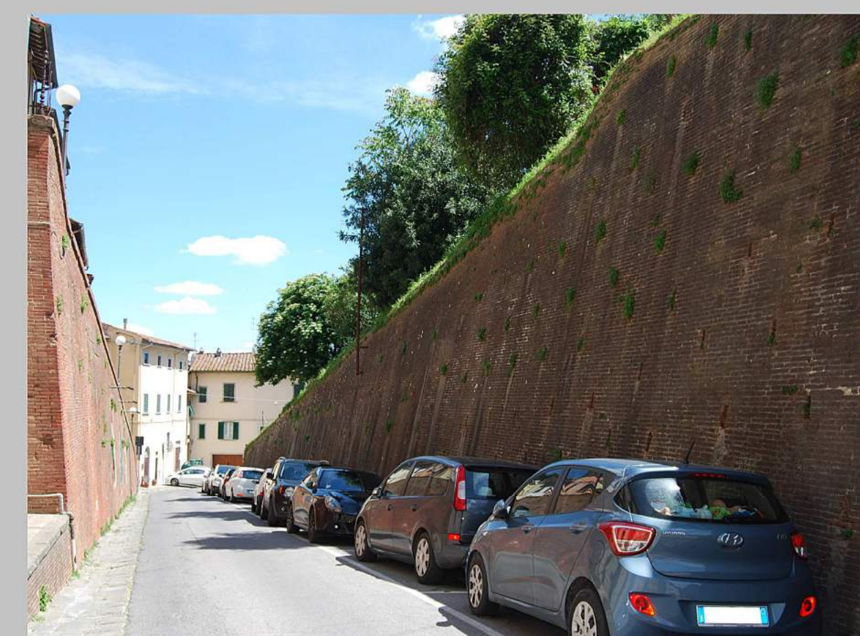
FOTO 9: Mura lungo Via 2 Giugno Intervento proposto: tipo 2
